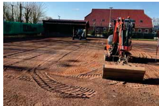
Die Sanierung hat bereits begonnen.
